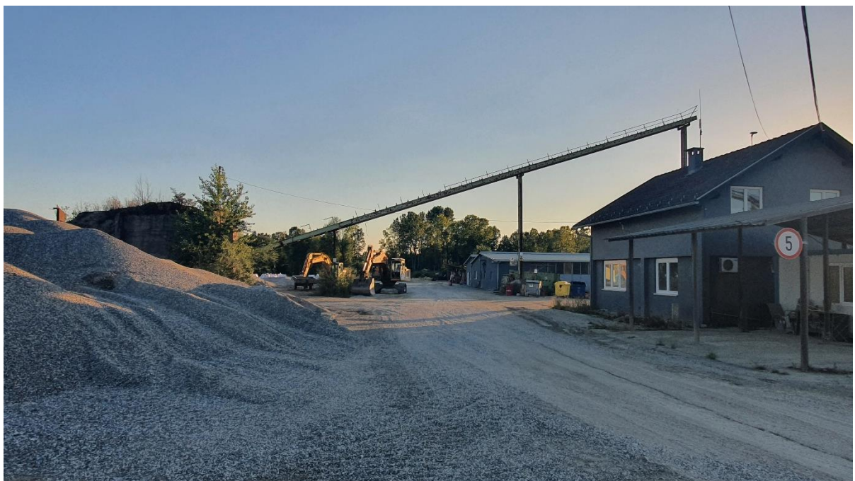
Slika 16. Postrojenje za separaciju šljunka u okviru eksploatacijskog polja šljunčare Abesinija (foto: K. Kovačec)
